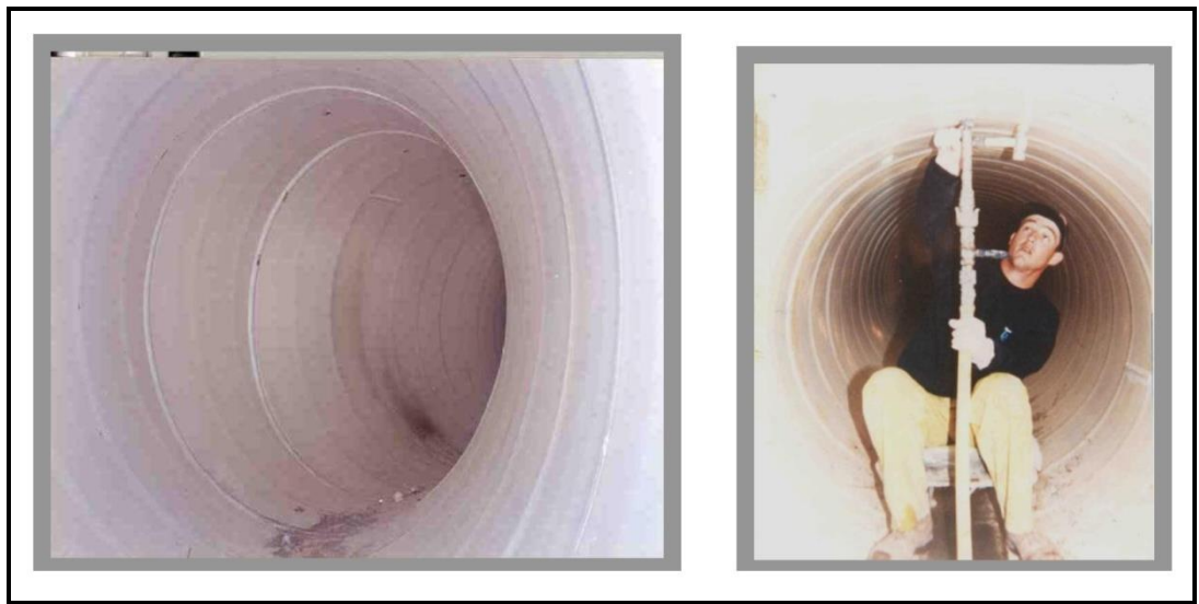
نحوه تزریق ماده پر کننده در زیر پوشش ماریپچ
